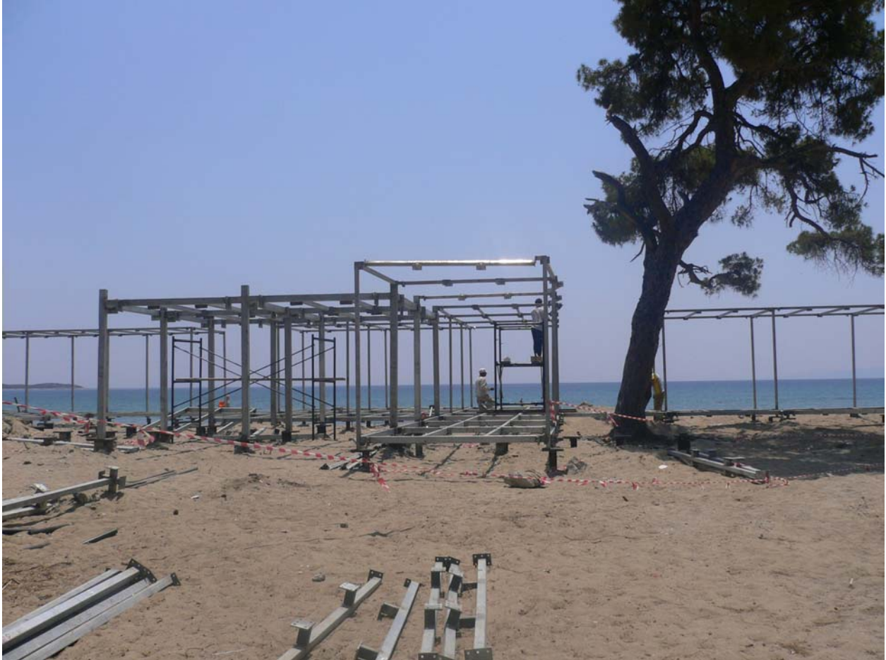
Εικόνα 4: Κατασκευή παραλιακού περιπτέρου
